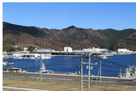
《対岸から見る漁港関連施設》
