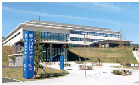
《法面が緑化された町庁舎》
