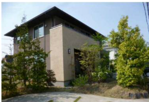
《敷地内を緑化した住宅》
