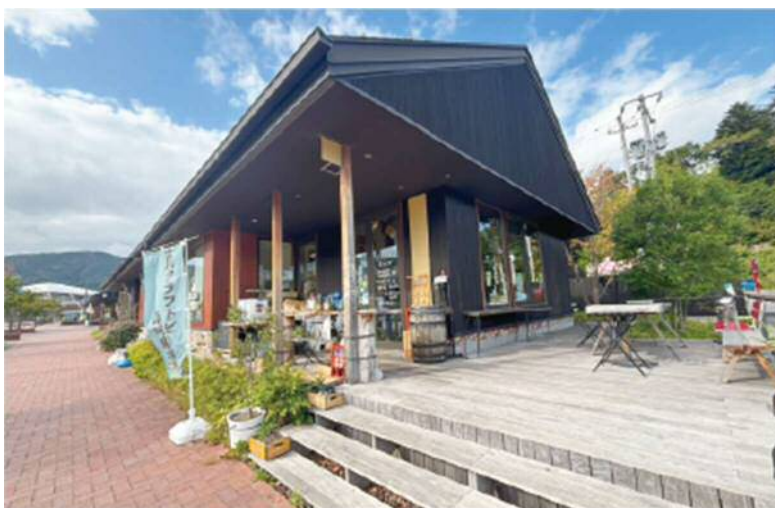
○ 建物の出入口が前面道路に面している
