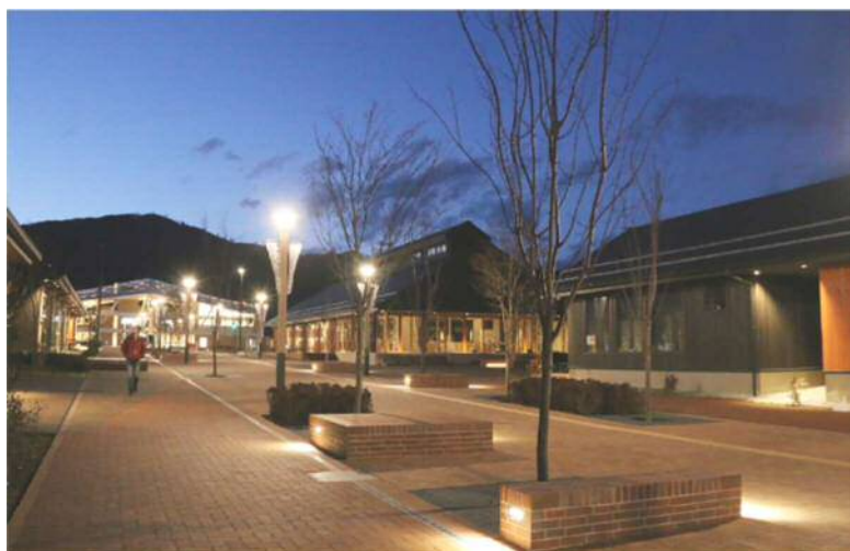
○ 照明を設置している
