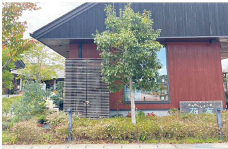
○ 建築物の設備を隠している
