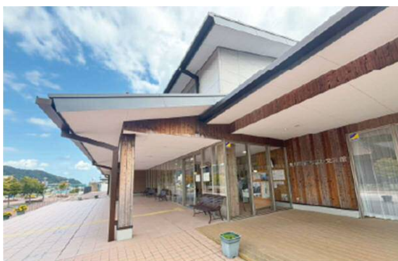
○ 庇を設置している
