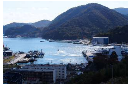
高台から見る漁港関連施設
