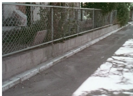
(下水道整備後)
