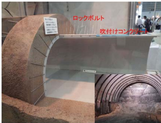
山岳工法(NATM工法)の断面模型と実際の掘削現場
