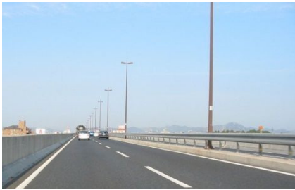
規則正しく配置した照明柱の例
