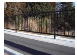
景観に配慮した転落防止柵の例
